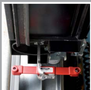
.Leading Safety Beam' – ruchoma fotokomórka bezpieczeństwa
